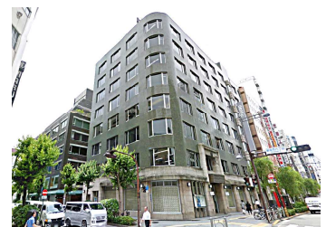
電通銀座ビル 昭和 8 年築
